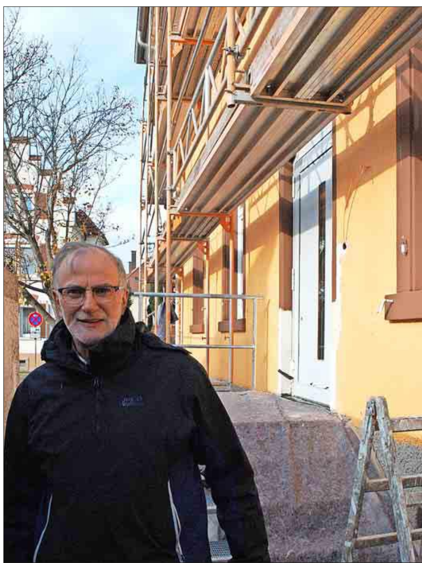
Noch sind die Arbeiten im Gang: Alfons Woestmann vor dem künftigen Eingang der Wärmestube.
